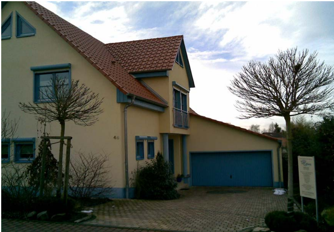
Seitenansicht rechts / Hauseingangsbereich
