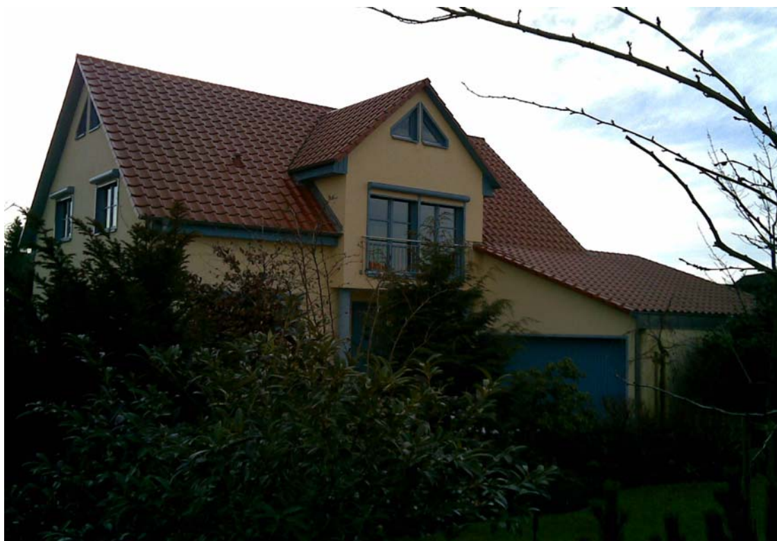
Seitenansicht rechts / Dachgaube
